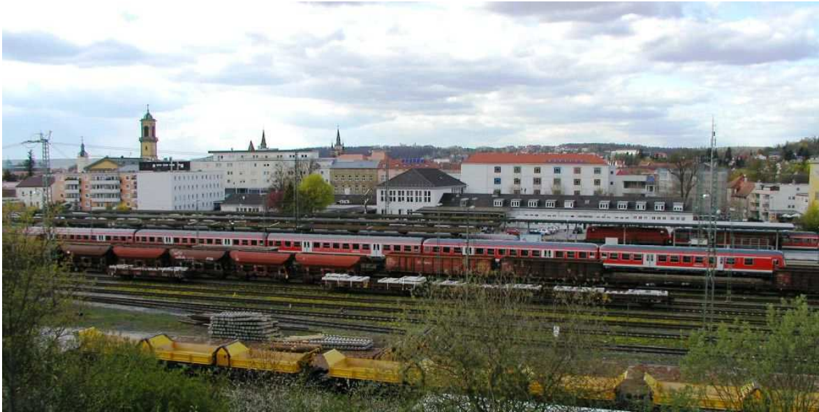
Bahnhof und Bahnhofsvorplatz (von Parkhaus Feuerbachstraße aus)
